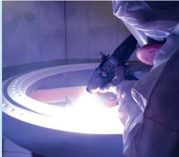
Bild 3: Beschichten eines Drehkranzes durch Lichtbogenspritzen (Werkstoff ZnAl) Fig. 3: Coating a slewing ring using arc spraying (spray material ZnAl)
